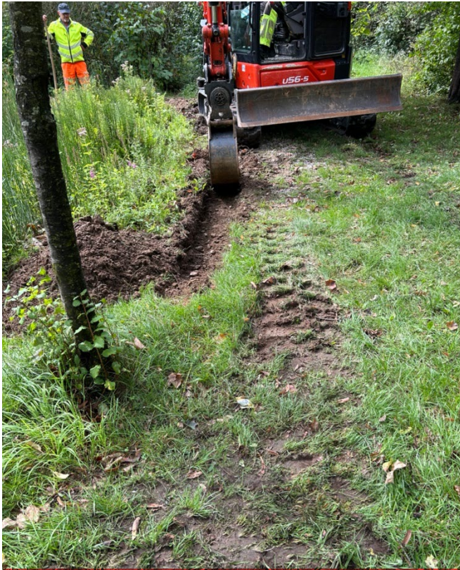
Abbildung 7: Der Graben für den Amphibienschutzzaun wird gezogen.
