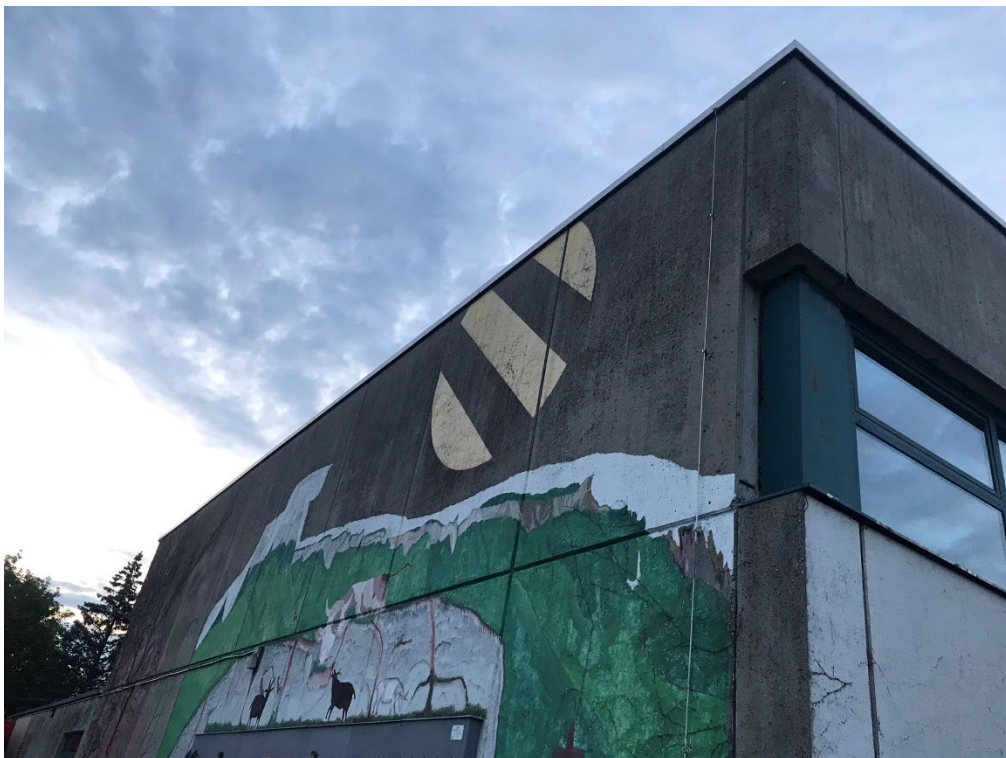
Abbildung 2: Westfassade der Turnhalle.
